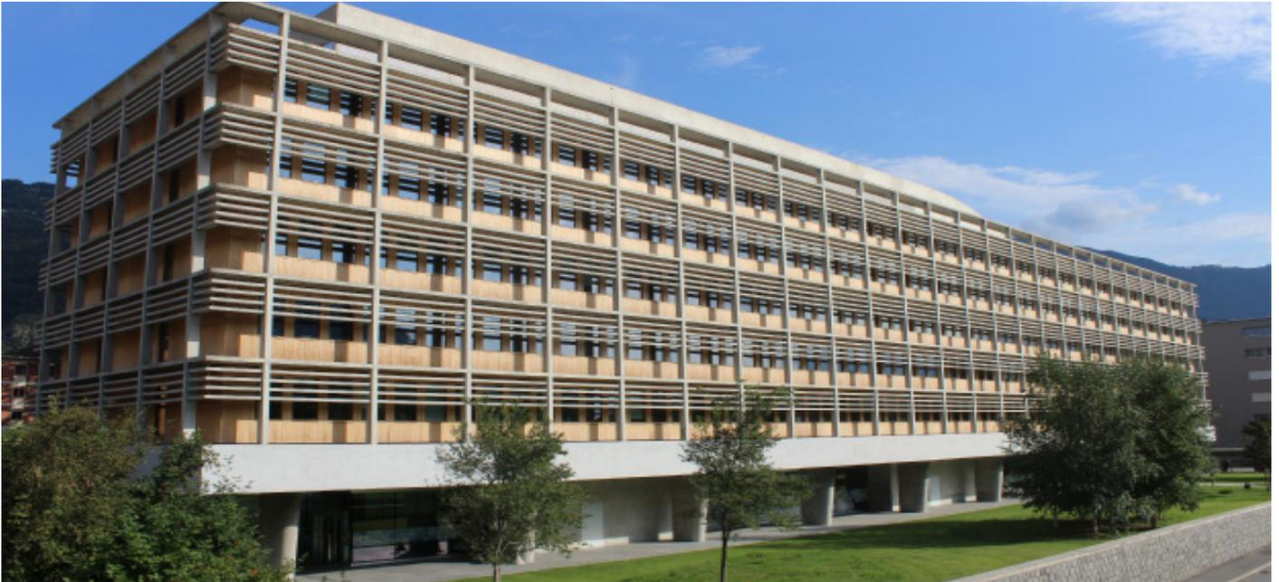
Das Projekt betrifft den Bau eines grossen öffentlichen Parks mit zwei Verwaltungsgebäuden. Das 5-stöckige Hauptgebäude beherbergt Büros für etwa 400 Mitarbeiter des Tiefbauamtes des Kanton Tessin. Sein oberer Teil, der durch zehn Pfeiler und eine Kassettenbetonplatte vom Boden abgehoben wird, ist durch eine "doppelte Haut" gekennzeichnet. Es besteht aus einer äusseren Schicht von Sonnenschutzelementen aus Beton und einer zweiten Isolierschicht aus Naturholz (Douglasia).
